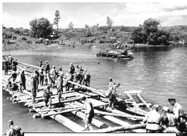
Советские саперы возводят деревянный мост через реку. На заднем плане вброд реку преодолевает самоходная установка СУ-152, на берегу реки расположились ещё несколько замаскированных единиц бронетехники.
